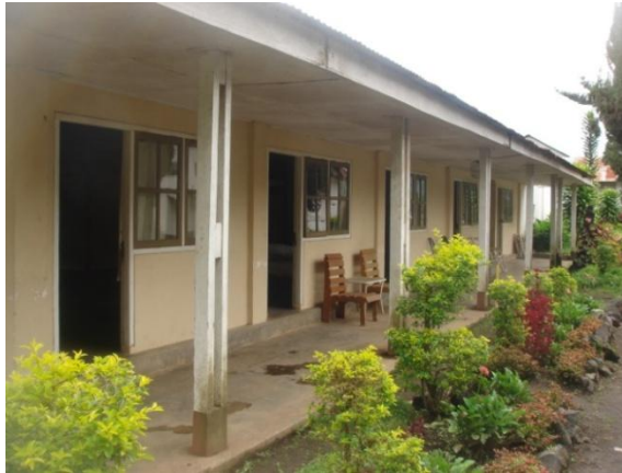
Gambar 1.7 : Kondisi bangunan penginapan di lokasi
