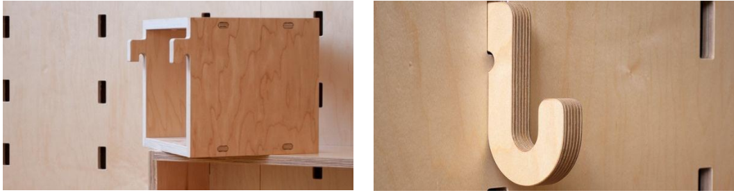
Gambar 4.8 Konstruksi modul ke modul dinding utama
