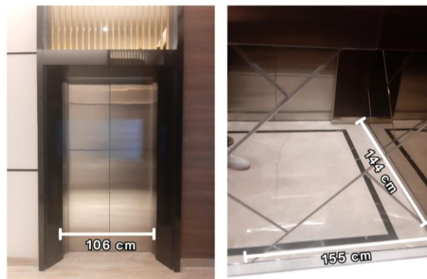
Gambar 4.1.2 Dalam Ruang Lift dalam Apartemen Vertu
